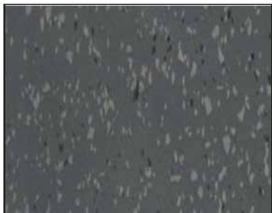
CODIGO: 1600112 INSTALACION DE PISO BUS
