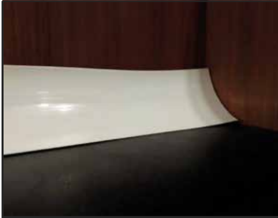
CODIGO: 1600201 INSTALACION DE CONTRAZOCALOS DE 5CM (COVE FORMER)
