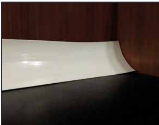
CODIGO: 1600203 INSTALACION DE ZOCALOS DE 5CM COLOR BLANCO (CON ACABADO)
