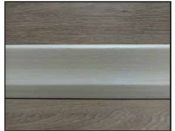
CODIGO: 1600220 INSTALACION DE ZOCALOS LAMINADOS (CON PEGAMENTO)
