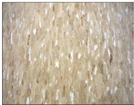
CODIGO: 1600111 INSTALACION DE BALDOSAS DE 3,2MM
