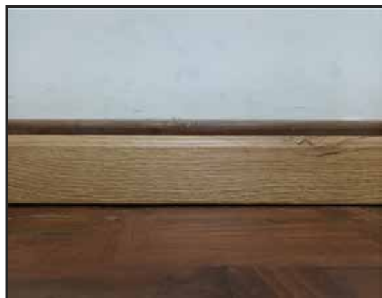
CODIGO: 1600218 INSTALACION DE ZOCALOS SPC (CON PEGAMENTO)
