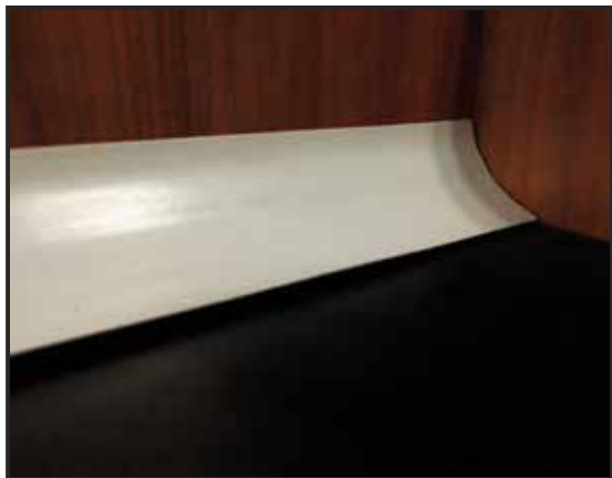
CODIGO: 1600207 INSTALACION DE ZOCALOS DE 8CM COLOR BLANCO (CON ACABADO)
