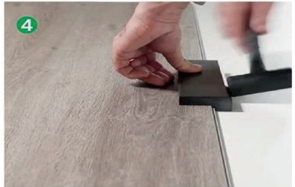
Use un martillo de cara blanda para ajustar adecuadamente las tablas
