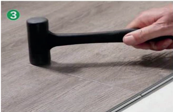
Use un martillo de cara blanda para ajustar las tablas en el lado corto
